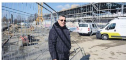
Gemeinderat Paul Hwiler freut sich, der Bevölkerung am 24. Februar die Baufortschritte zu zeigen.
