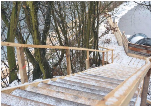
Diese Treppe führt zum über 60 Meter langen Steg, der entlang des Reussufers frei im Wasser steht. Die Baute dient auch als Abgrenzung des Wettkampfgeschehens vom Kraftwerkareal, was dem Wunsch der AEW Energie AG entspricht.
